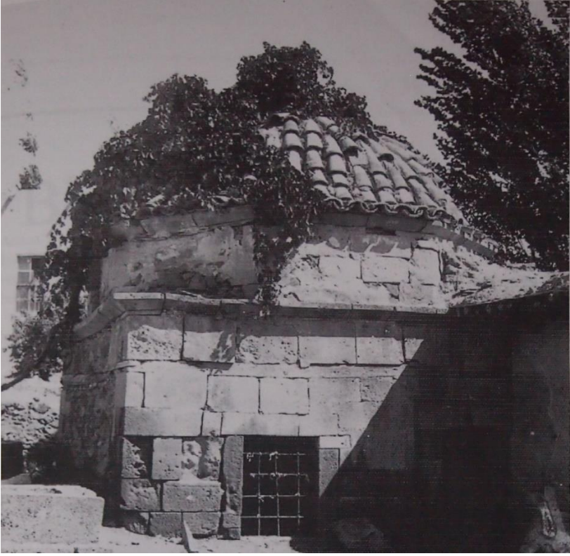
Foto 1: Onarım öncesi Sarı Saltuk Türbesi (E. Atlı, Geçmişten Günümüze Bor, 1998)
